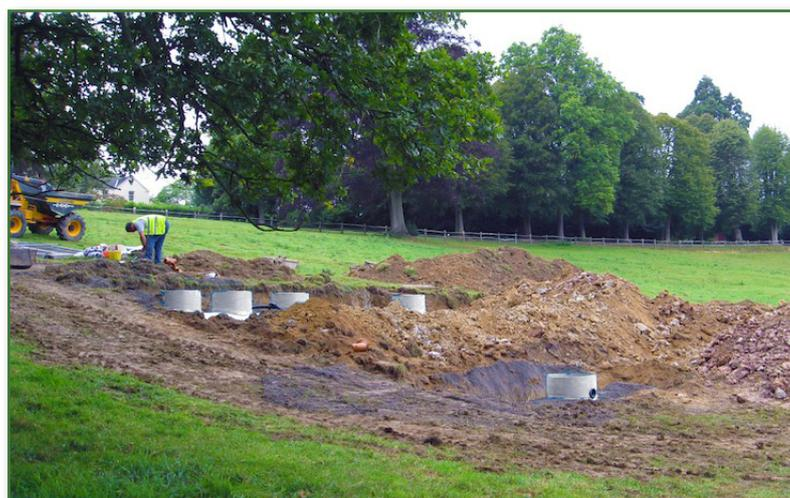
pour réduire les frais de terrassement. Ces filtres Polylok® réduisent d'avantage les MES et le DBO5. La station contient également un système de recyclage interne pour contrebalancer les charges. La station était installée en trois jours et atteint faiblement des résultats d'effluent au rejet de 4mg/l en Ammoniaque et 7.8mg/l en DBO5.
