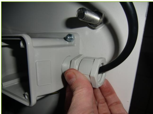
**5) Brancher la prise male dans la prise femelle et serrer la bride d'étanchéité.**
