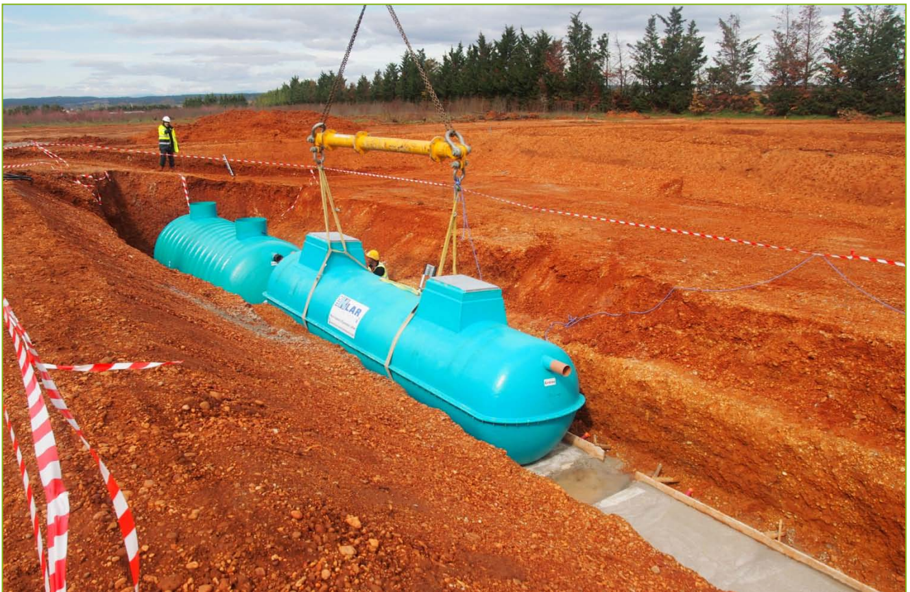
En exemple de pose terrassée pour éviter une profondeur excessive, et faciliter l'entretien.
